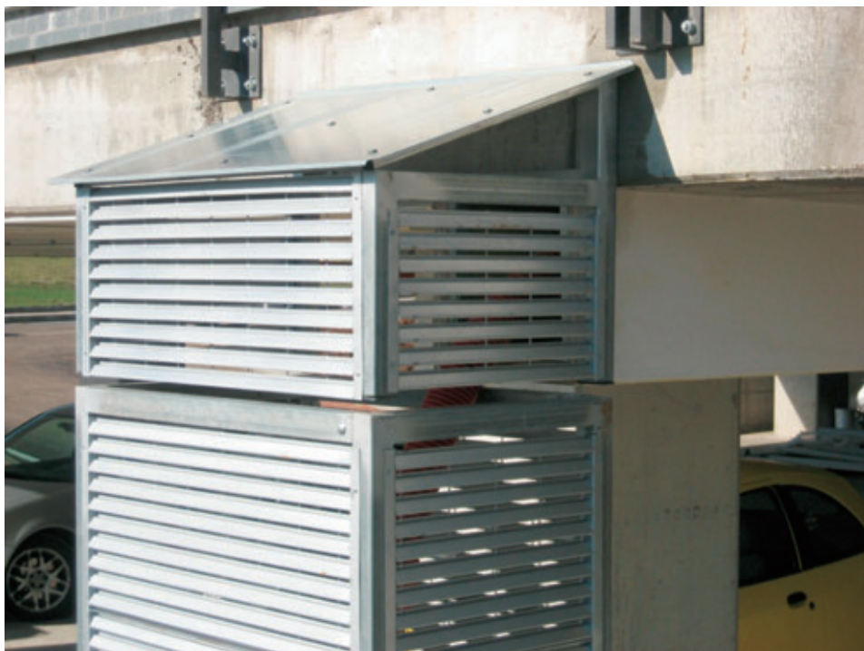
Figura 22 – Giunto sismico per il collegamento ENEL.
