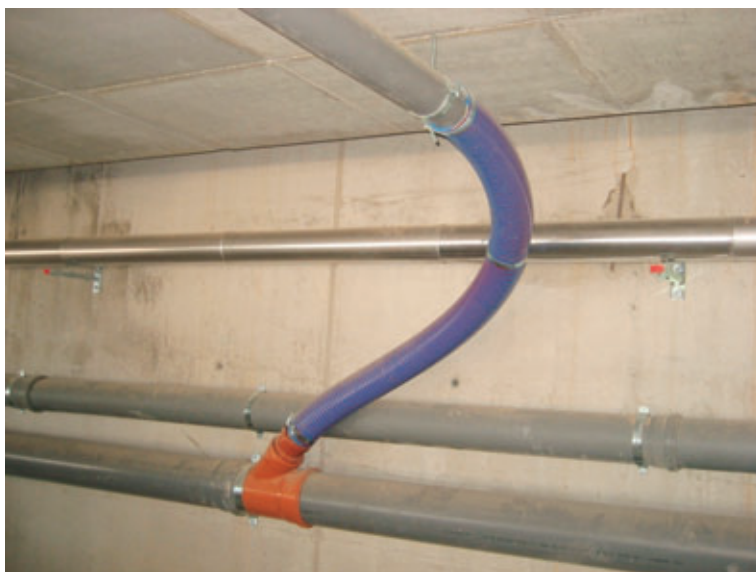
Figura 33 – Giunto antisismico per il collegamento delle reti di scarico acque B/N.
