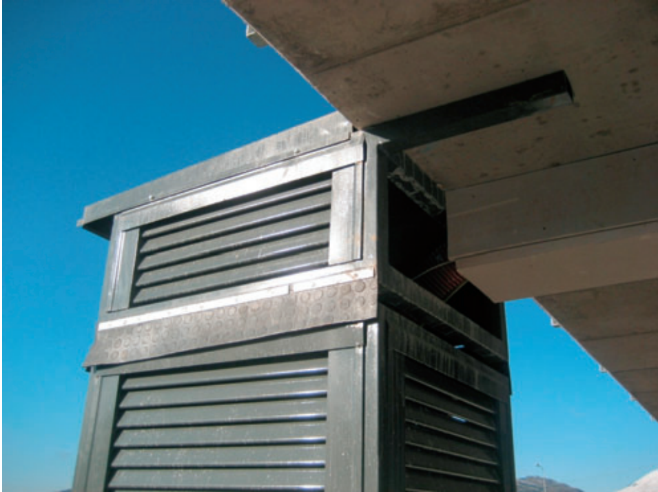
Figura 24 – Giunto sismico per il collegamento ENEL.
