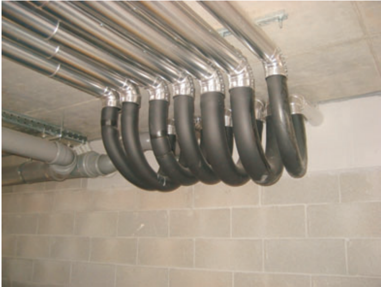
Figura 39 – Giunti flessibili in acciaio per l'impianto centralizzato.
