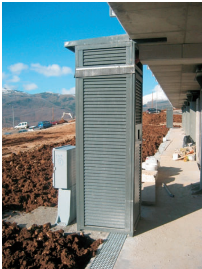
Figura 23 – Protezione in orso grill del collegamento ENEL.
