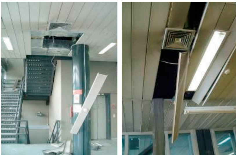
Figura 6 – Effetti dell'interazione tra componenti strutturali, impiantistici ed altri componenti costruttivi non strutturali dovuti a moti relativi. Centro operativo delle Poste Italiane L'Aquila. Terremoto de L'Aquila 2009.
