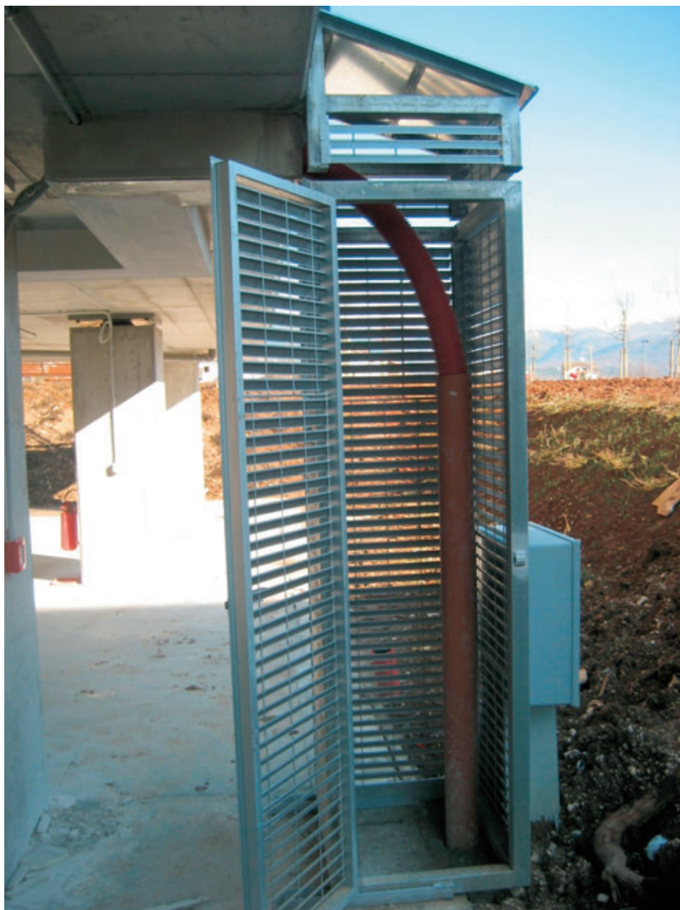
Figura 20 – Giunto sismico per il collegamento ENEL.
