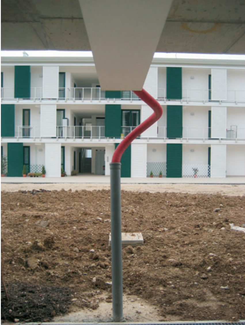
Figura 16 – Cavidotto Enel.
