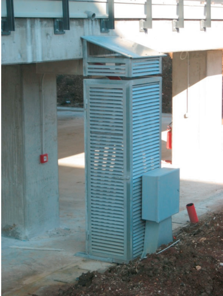
Figura 18 – Giunto sismico per il collegamento ENEL.
