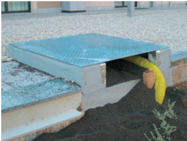
Figura 28 – Giunto sismico per il collegamento ENEL GAS.
