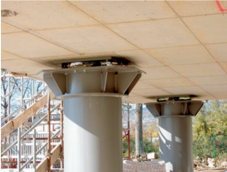
Figura 5 – Isolatore sismico.
