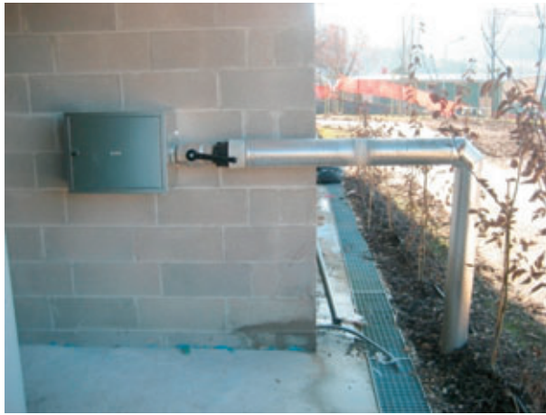
Figura 13 – Isolamento termico acquedotto.
