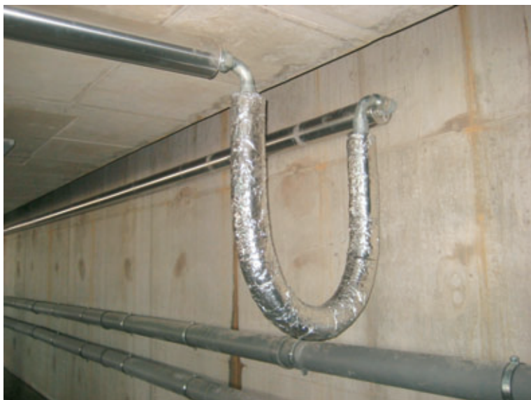
Figura 12 – Giunto sismico per il collegamento dell'acquedotto.
