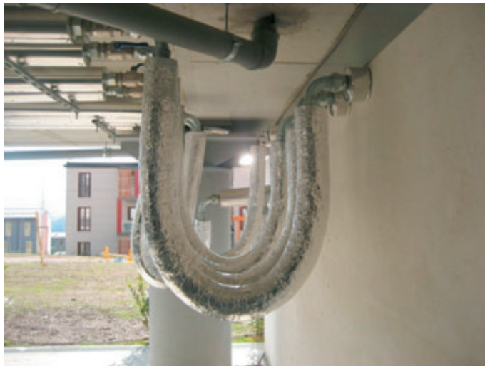
Figura 39 – Giunti flessibili in acciaio per l'impianto centralizzato.
