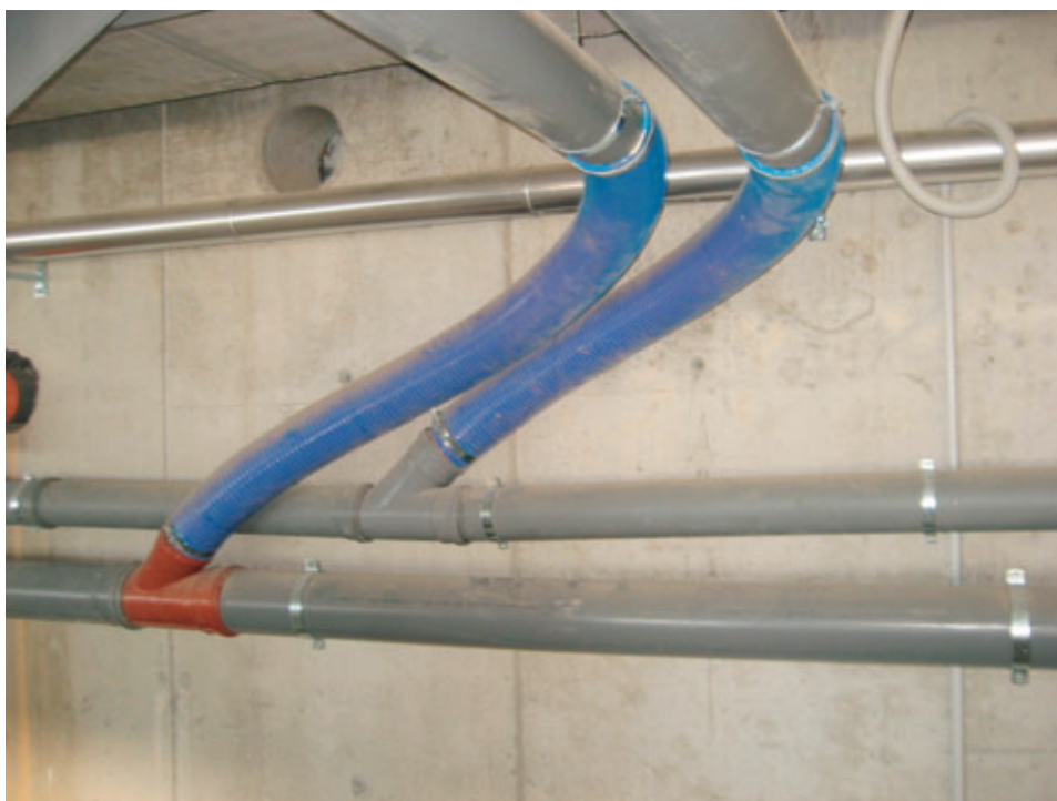
Figura 32 – Giunto antisismico per il collegamento delle reti di scarico acque B/N.
